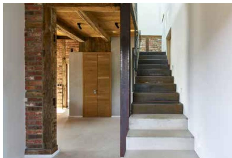
Ins Obergeschoss führt eine Treppe aus einem Betonfertigteil, das durch Metallstufen ergänzt wird.
