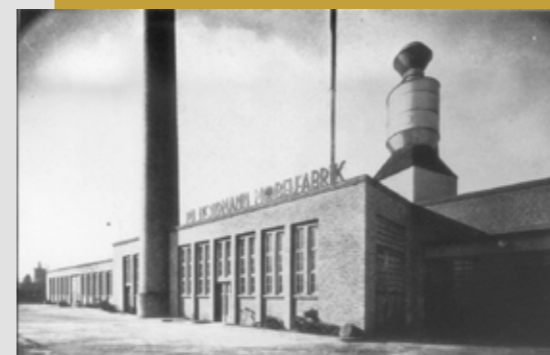
Die Möbelfabrik Philipp Nordmann in Gütersloh, Neuenkirchener Straße.
