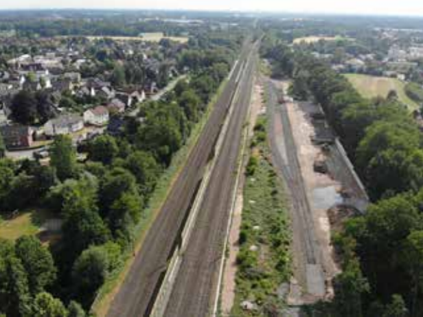
Luftaufnahme während der Gleisarbeiten.
