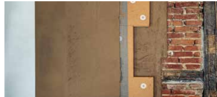
Aufbau einer Lehmwand.
