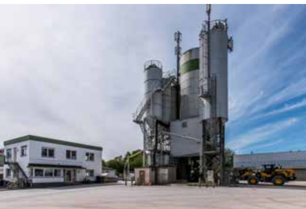
Die Mischtürme von Grün-Weiß-Beton an der Isselhorster Straße in Gütersloh-Avenwedde, circa 500 Meter vom Güterbahnhof entfernt.
