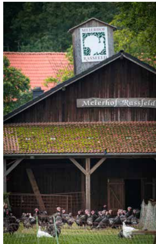
Der Meierhof Rassfeld gibt Puten viel mehr als ein Dach über dem Kopf.
