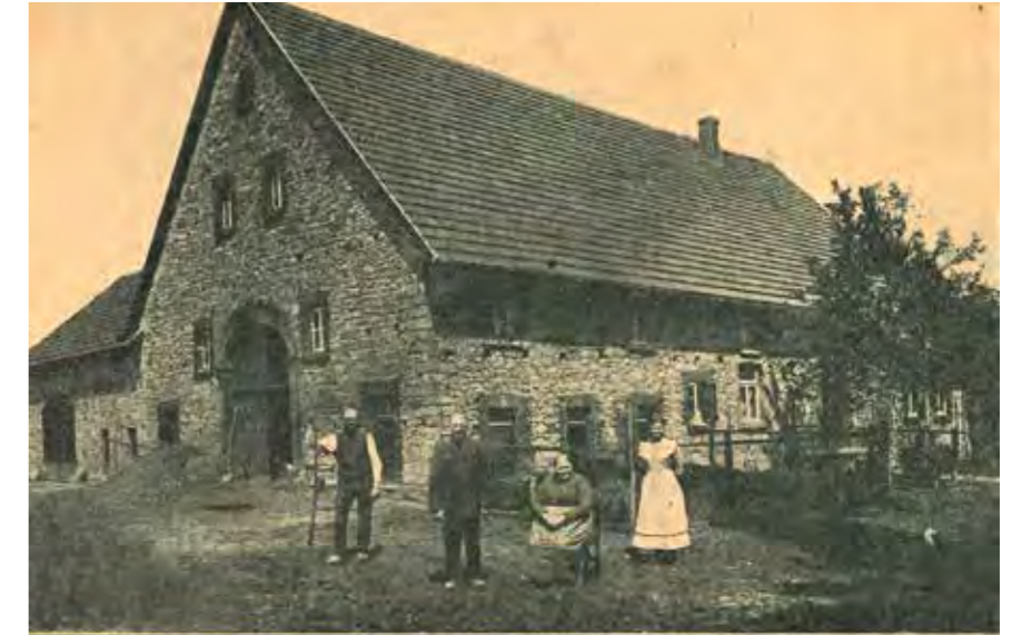
Fig. 10. — Ferme de M. Steinmann à Barnhausen (Westphalie). Au premier plan, le personnel de la ferme en 1914. La grande porte voûtée ménagée dans le mur de pignon visible sur la photographie représente l'entrée de la Diele.
